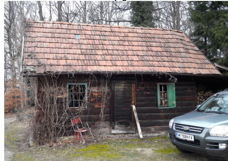
SITUATIONSFOTO - Hauptgebäude: Stand Feb. 2019
